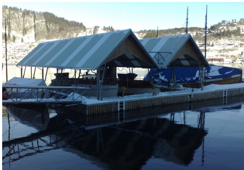
Hardanger fartøyvernssenter har bygget disse "båtgarasjene" for fartøy som ligger i opplag der. Garasjene gir rikelig med lufting og beskytter samtidig godt mot nedbør.
