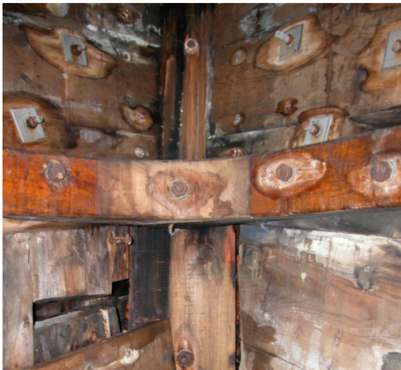
Rustne jernbolter danner lut-råte med misfarging og begynnende nedbrytning av treverket som følge.
