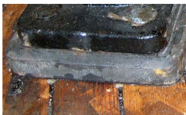
Skjørnaglen er satt på rett plass for å forhindre vanninntrengning under pullerten.
