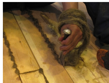
Støten på bildet drives med kryssende tråd. Neste tråd settes fra motsatt side og via støten.
