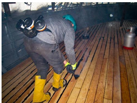
Her brukes ei øse til å fylle bek i natene. Friskluftmaske, med riktige filter for oppgaven, er et fint hjelpemiddel.
