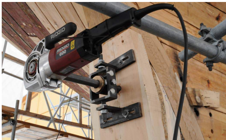
Her er hylseboret montert i pilothullet, og klart for første snitt. Boret består av en aksling med gjenger i ene enden. I huller på akslingen monteres justerbare skjær. Akslingen kan justeres i alle retninger ved hjelp av opphengene, og drives rundt av en gjengemaskin. Se for øvrig faktaark: «Boring for gjennomføringer i trefartøy».
