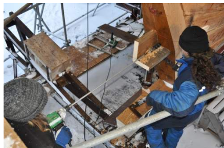
Boring av pilothull. Plassering av hull er basert på utvendig mål på gammel stevn. Helning er tatt med digital water på motorfundament.
