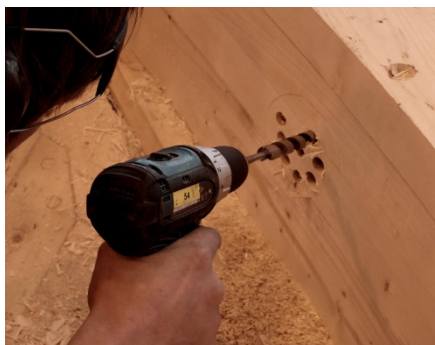
Når man har merket av på både ut- og innsiden, kan man begynne å bore mellom sirkelene.
