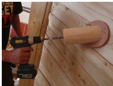
Boremalen er en «kopi» av klysset, som skal an vise riktig vinkel på pilothullet.
