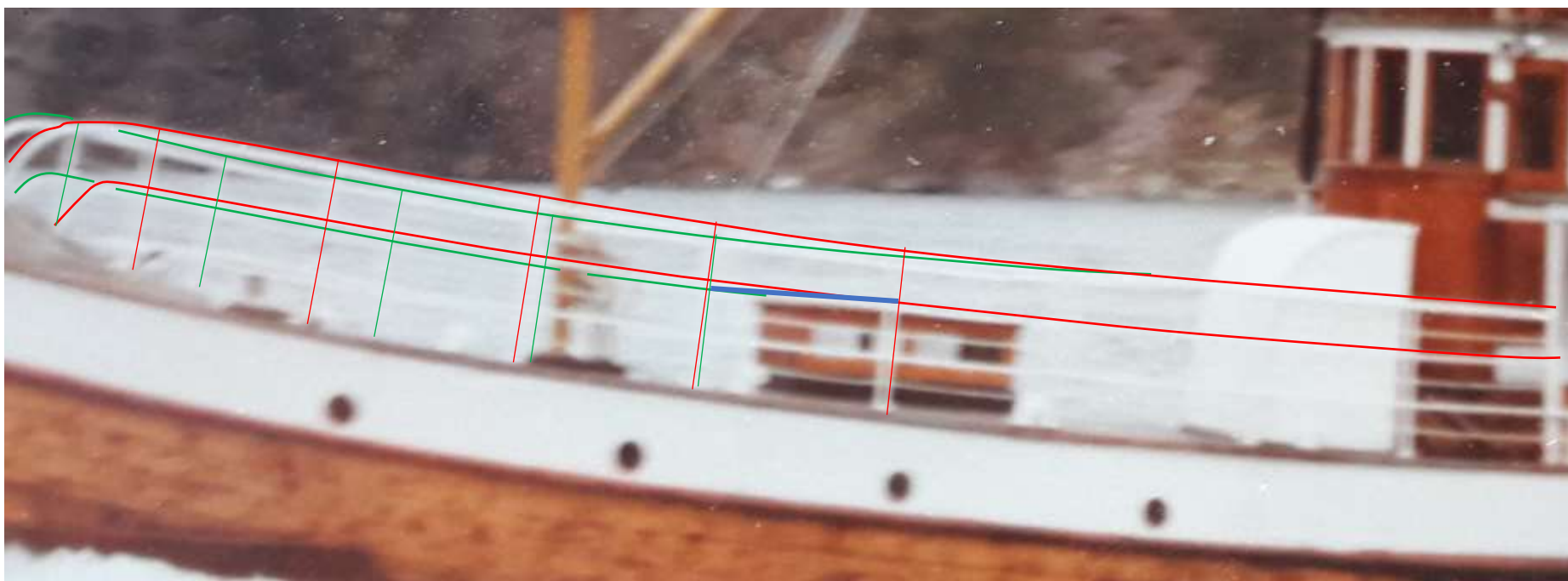
Figur 101 Same metode som på Figur 100 er her brukt på eit anna fotografi. Resultatet er det same: Skylight-taket er på nivå med nest øvste røyret i rekka. Senter på dette røyret er 53 cm over dekk. Med fråtrekk for bjelkebukt (9 cm) vert totalhøgda på skylightet då ca. 45 cm målt ved over senterlinja. Karmen er måla og derfor truleg ikkje laga av teak men av furu.
