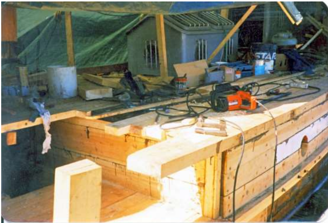
Figur 87 Ombygging i 1988. Fotograf: Trond Blakstad.
