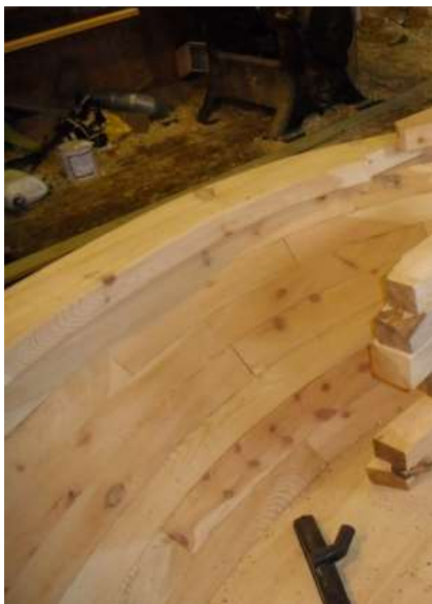
Figur 39 Mura rekke etter restaurering
