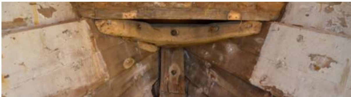
Figur 26 Baugband og livholt. Foto HFS, 2020
