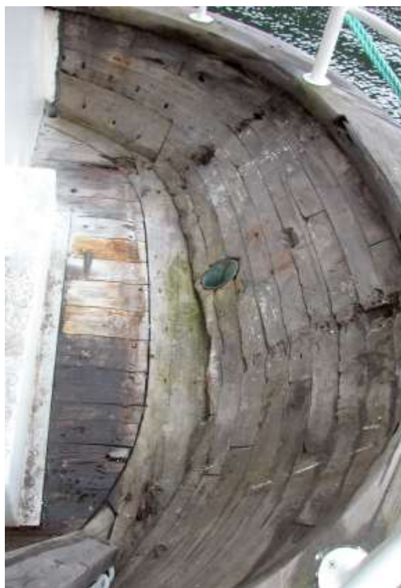
Figur 40 Før restaurering. Foto: HFS, 2005
