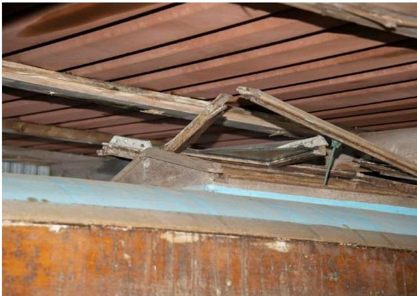
Figur 36: Hyttetaket (t.v.) er framleis dekt med glasfiber. Spor tyder på at det også var nytta glasfiber på dekket, som seinare er blitt fjerna m.a. ved hjelp av vinkelslipar.
