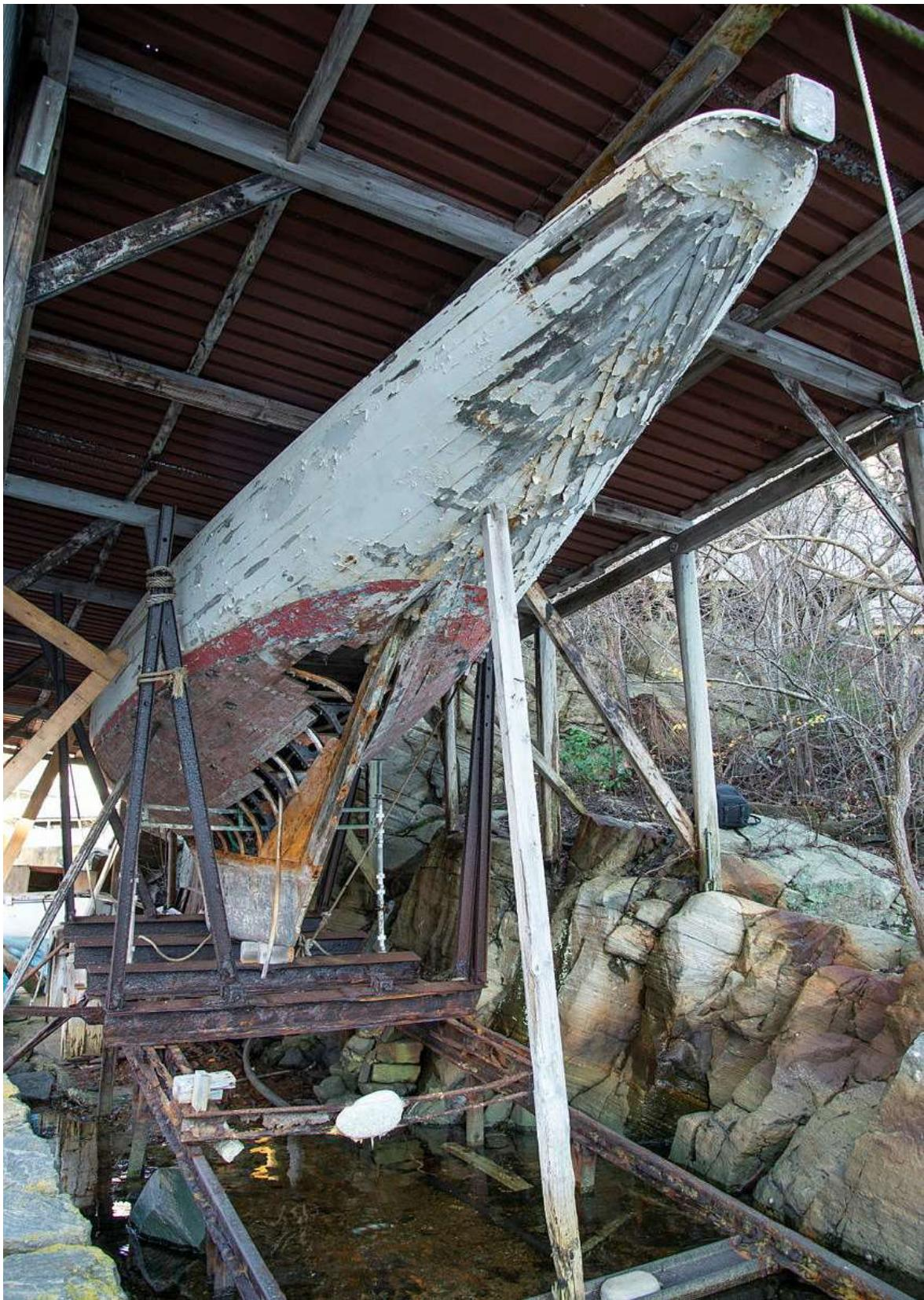
Figur 1: Som biletet viser er det store rustskadar på slippen, der båten har stått sidan 1975. Det er grunn til å tru at rustskadane på nedre del av stålkonstruksjonen (spant) i båten har auka på etter at dei nedste hudplankane vart tekne bort midt på 1970-talet.
