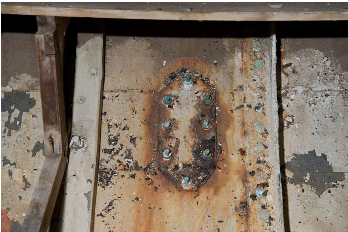
Figur 49: Der hudplankane er skøyte er det skrudde stålplater på innsida som forsterking.
