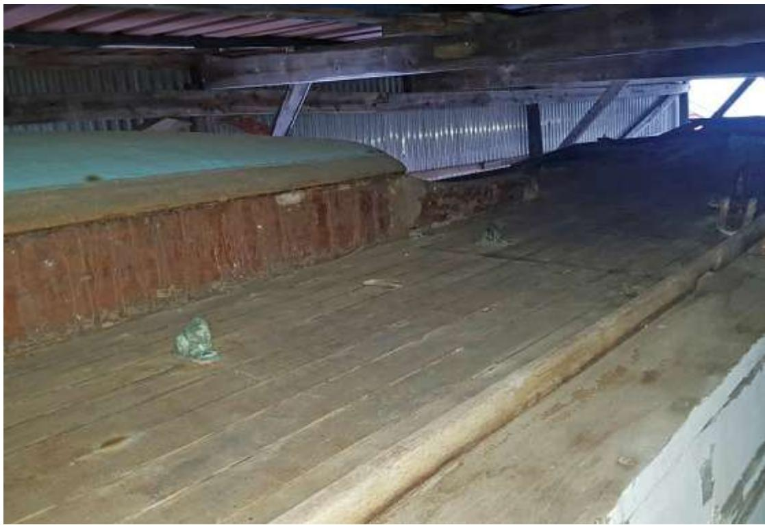
Figur 54: Brand VI vart teikna med dekk i gran, kledd med seglduk, men båten har truleg hatt dekk i oregon pine, utan seglduk, sidan starten. Som biletet viser, er det framleis glasfiber på hyttetaket. Det er grunn til å tro at det har vore glasfiber på dekket også. Det er spor etter sliping på dekk, truleg frå fjerninga av glasfiberen.
