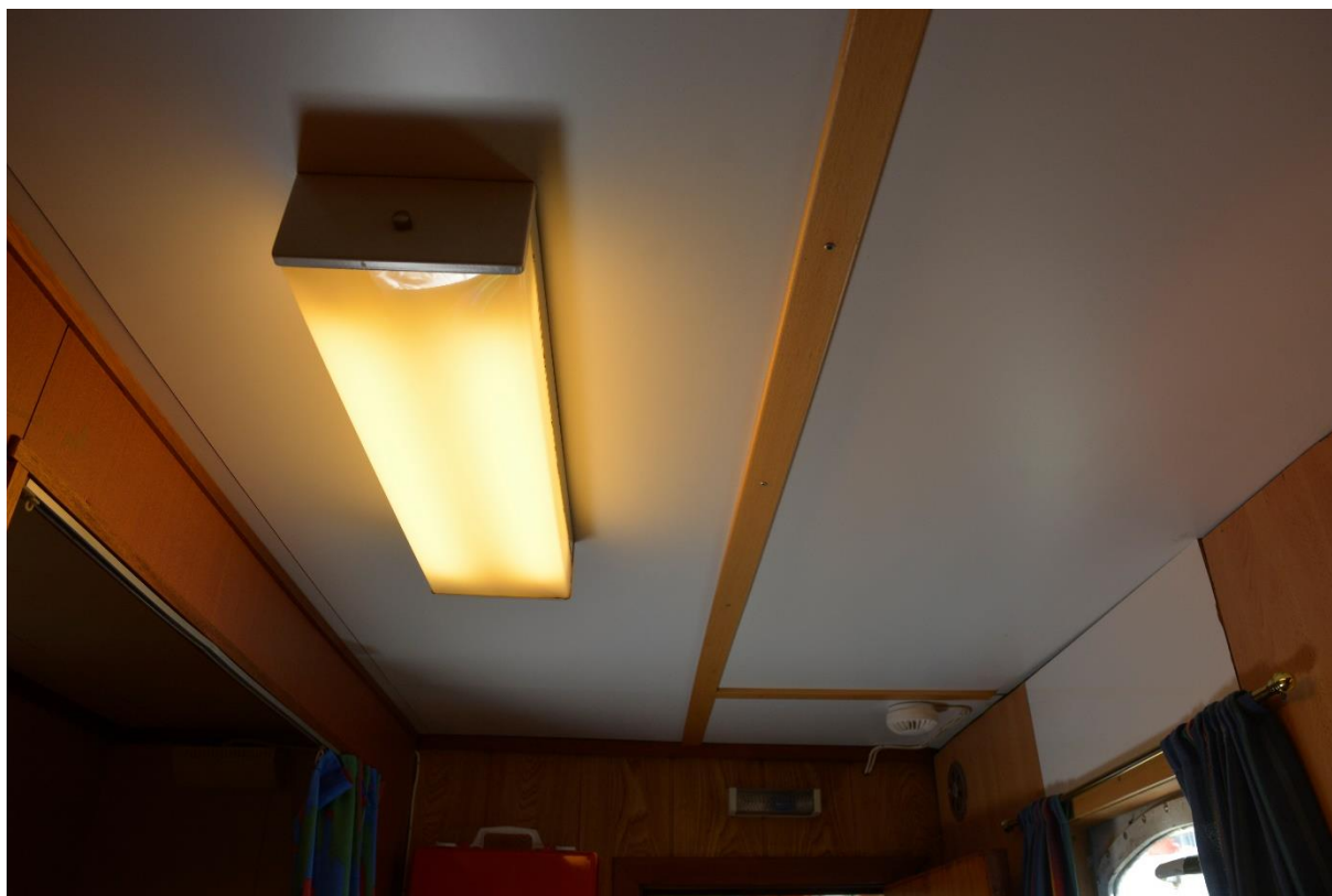
Figur 35 Himling i kapteinslugaren. Hvite plater med lister over skjøtene. Foto HFS 2020
