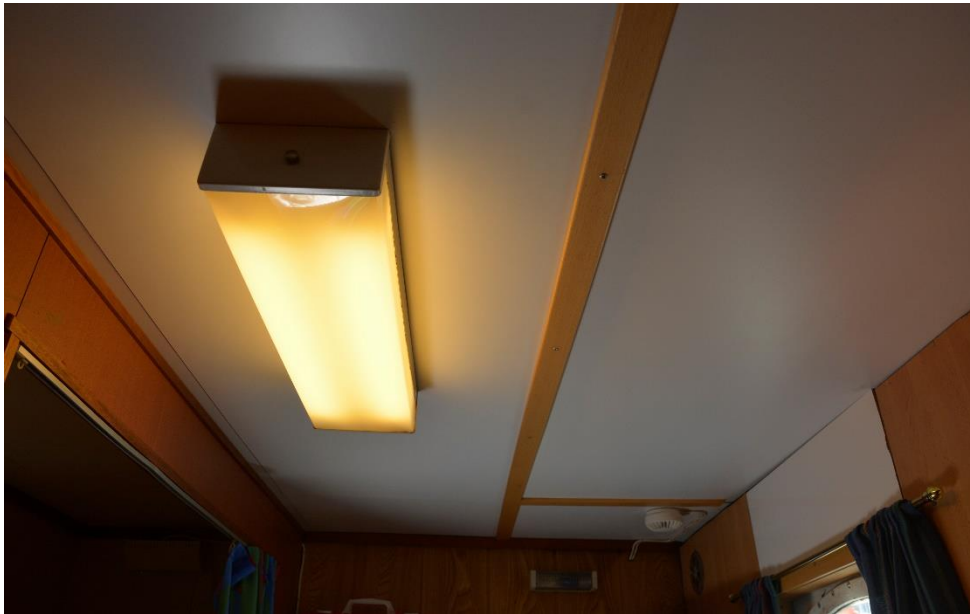
Figur 5 Himling på kapteinslugaren. De gamle platene er satt fast med lister. Foto HFS 2020
