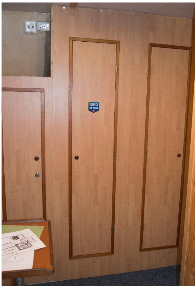
Figur 32 Skap på akterskott etter ombygging. Det skal være listet på dørk og i himling som på figur 26. Foto HFS 2017
