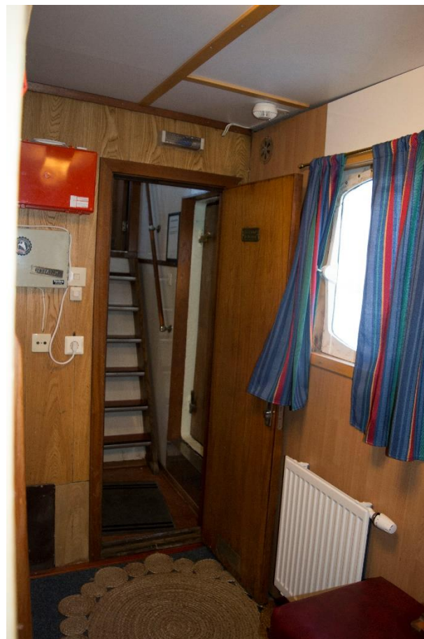
Figur 33 Stybord skott etter ombygging. Platen over vinduet skal også være i bøkeleraminat. Radiatoren har kommet til i periode III. (2000) Her skal opprinnelig være en elektrisk ovn. Foto HFS 2017
