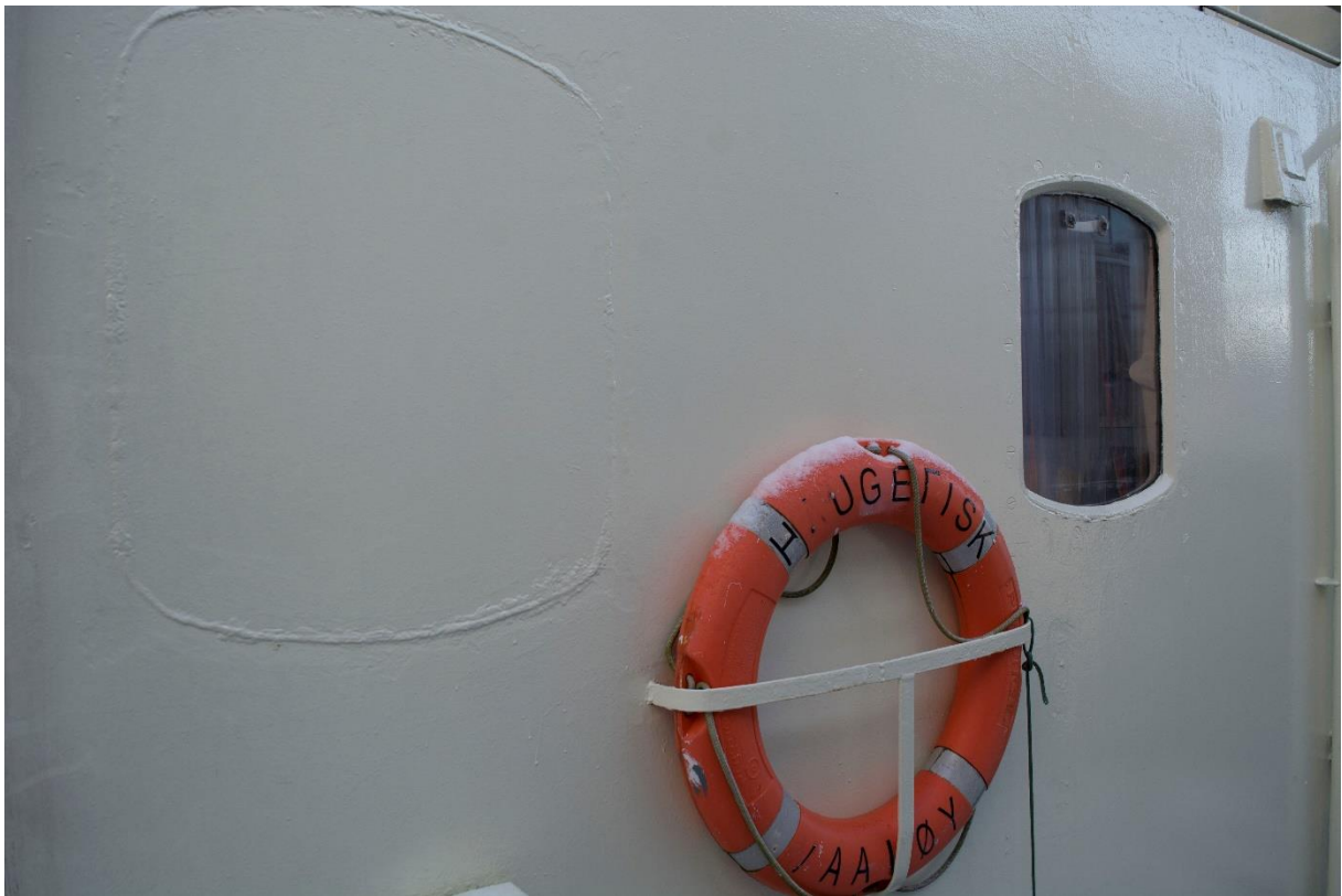
Figur 34 Akterste lysventil er sveiset igjen i forbindelse med oppbygging rundt 2000. Foto HFS 2017
