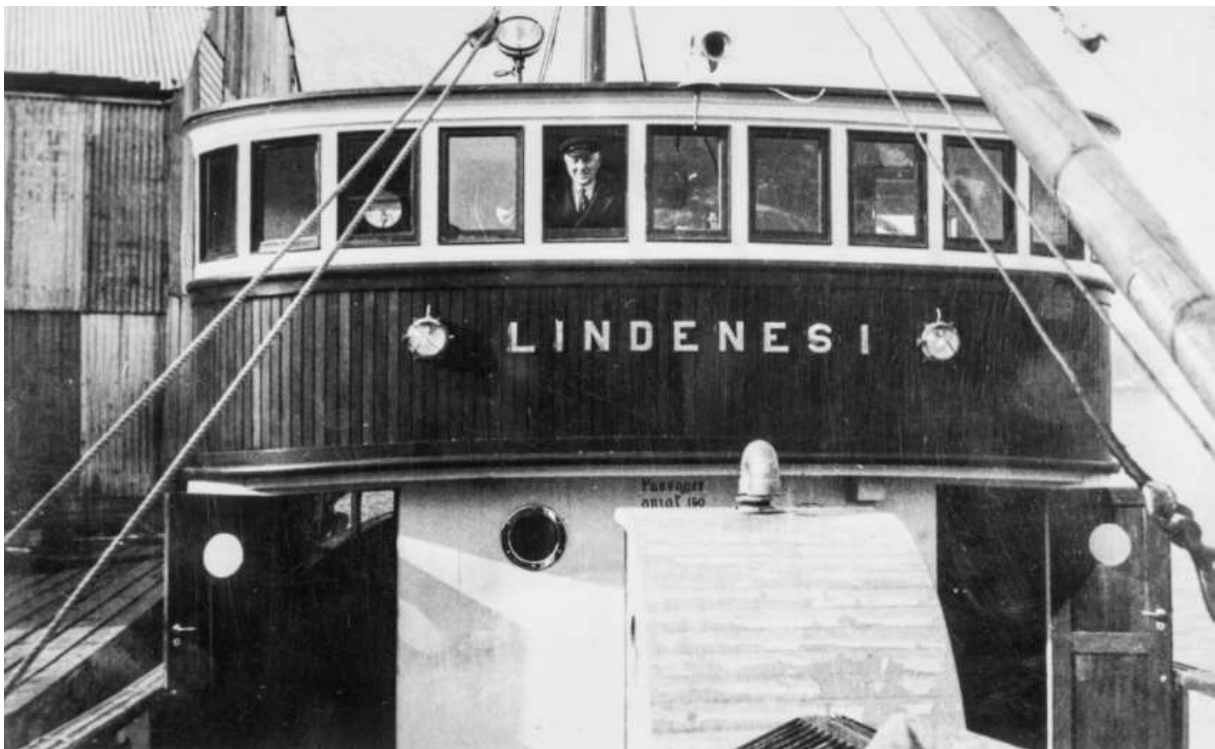
figur 21: Overbygg sett forfra, ca. 1946 (utsnitt av figur 125).
