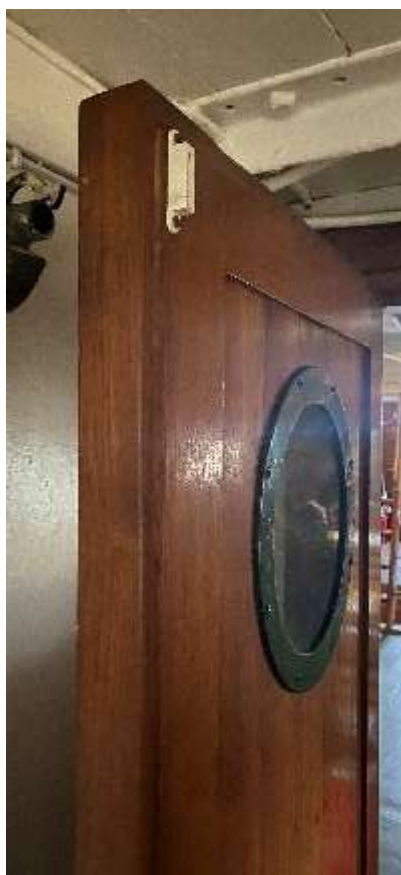
figur 75: Dør i styrbord skott mellom dekkssalong (230) og akterdekk (220), 2021.
