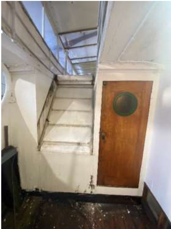
figur 68: Skott mellom dekkssalong (230) og akterdekk (220) babord, 2021. Skottet er bygget i 1950.
