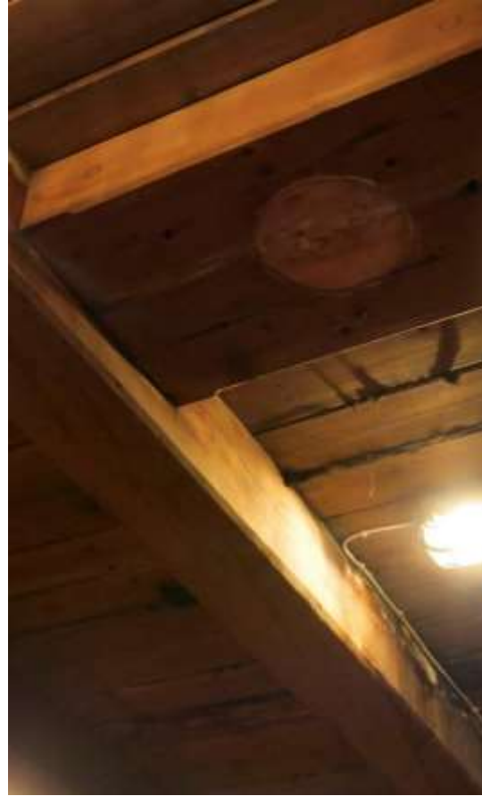
figur 14: Spor etter fjerde jernstøtte, 2015.
