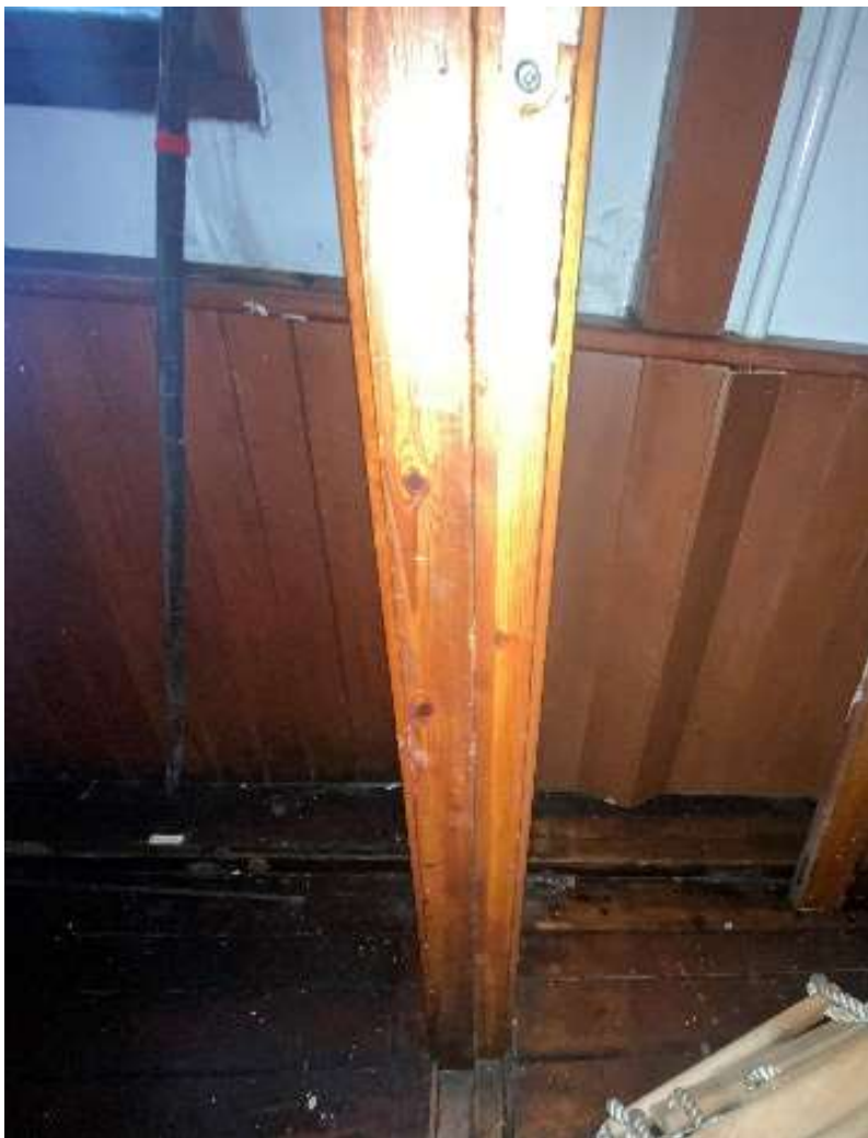
figur 80: Brystningspanel fra 1950 til venstre og fra nyere tid til høyre. Bildet er tatt i døren mellom passasjersalongen og akterdekket., 2021.
