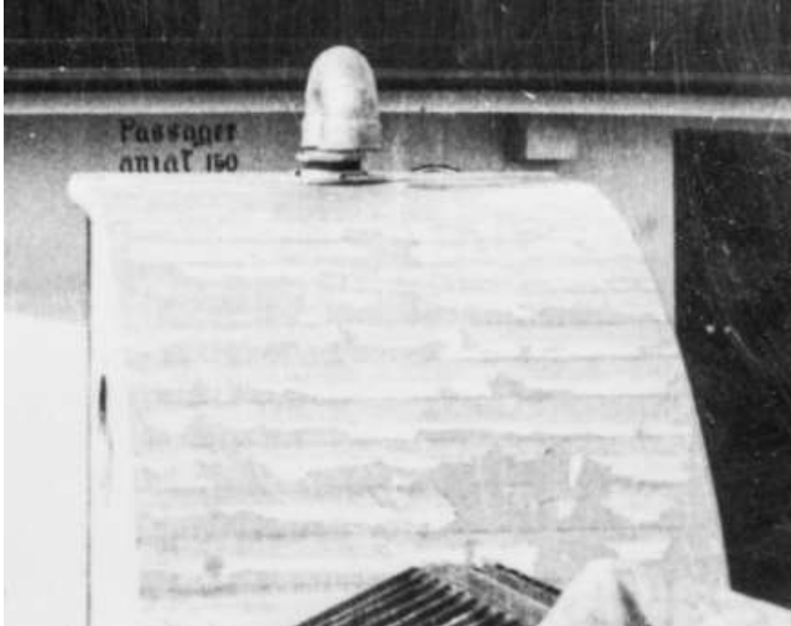
figur 40: Nedgangskappe (212), 1945. Her er bord i taket tydelige. Lufteventilen er byttet etter 1950. Ukjent materiale (utsnitt av figur 125).
