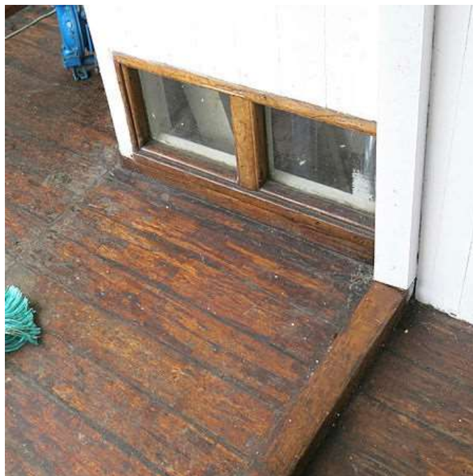
figur 50: Vindu langs akterdekk, 2015. Det er tilsvarende vindu til maskinrom.
