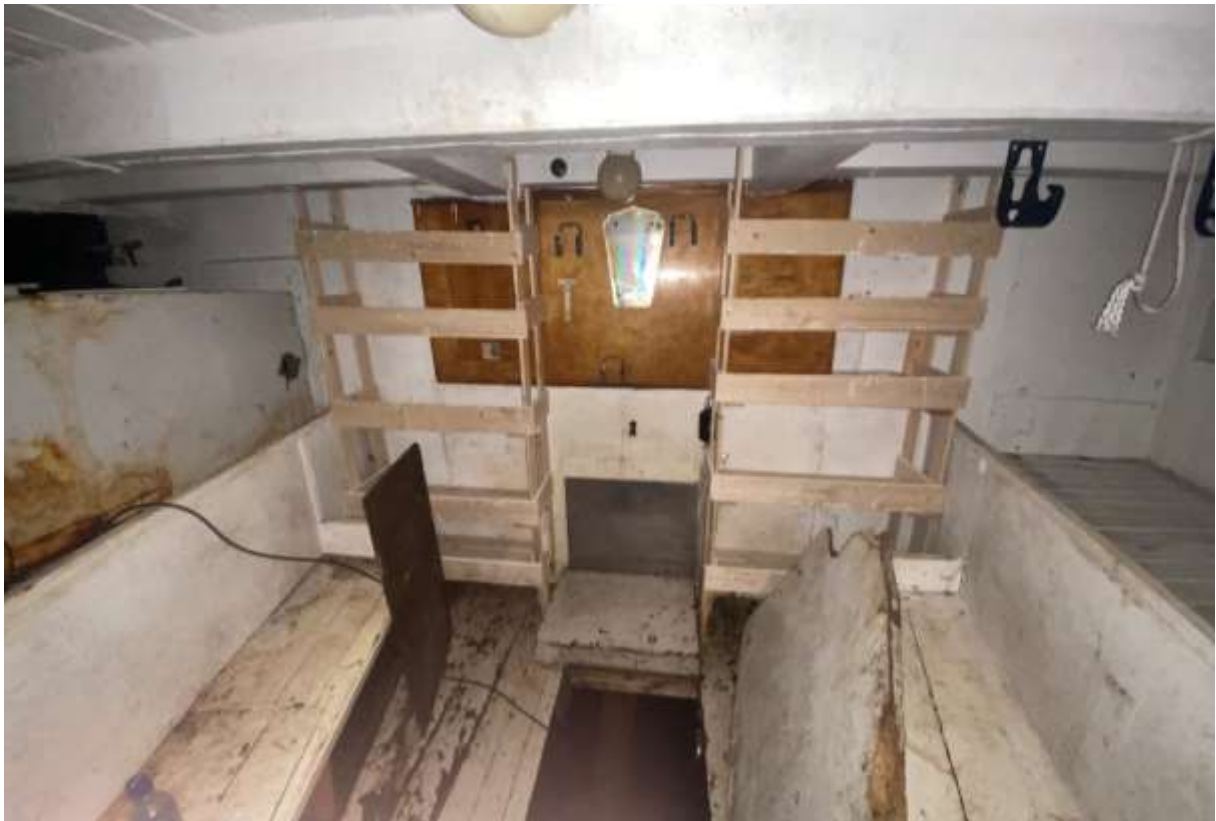
figur 62: Akterlugaren sett forover, 2021. Spor etter trappeavsatsen og luken til nedgangen fra 1943. Kravellene til luken forsvinner gjennom skottet og et lite stykke inn i maskinrommet.
