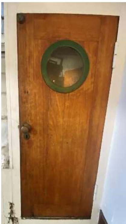
figur 73: Dør i babord skott mellom dekkssalong (230) og akterdekk (220), 2021. Dør til akterlugar er lik.
