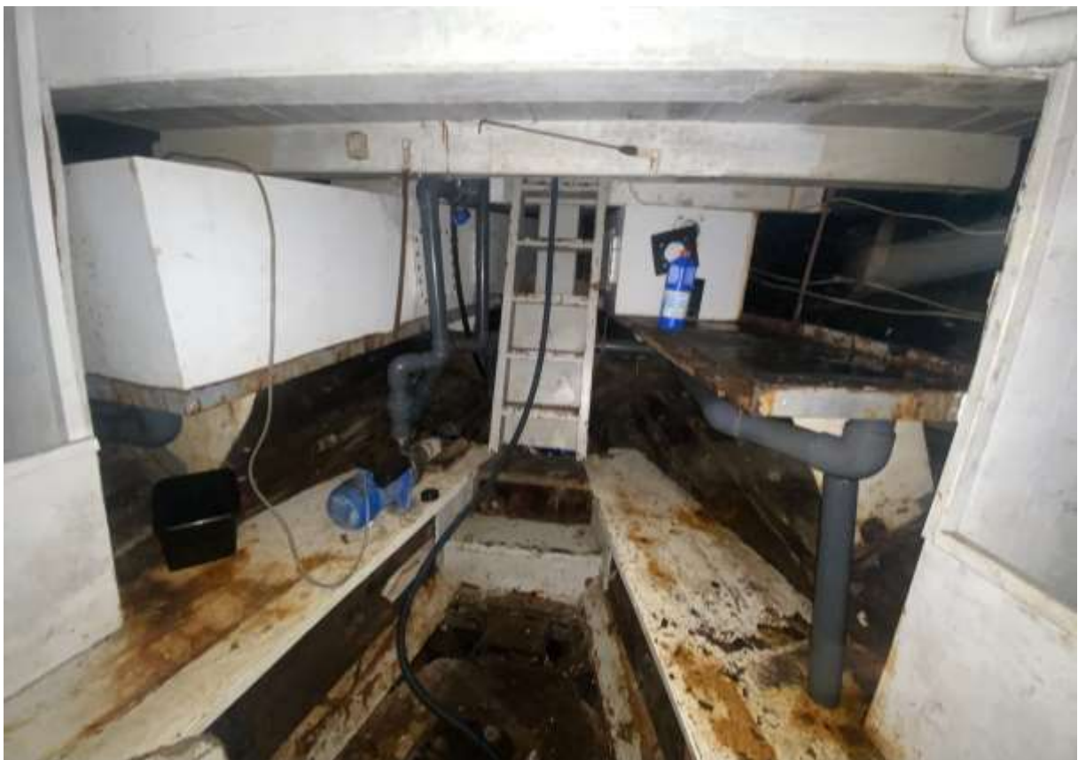
figur 63: Akterlugaren sett akterover, 2021. Leieren og nedgangen har sannsynligvis kommet til med ombyggingen i 1950.
