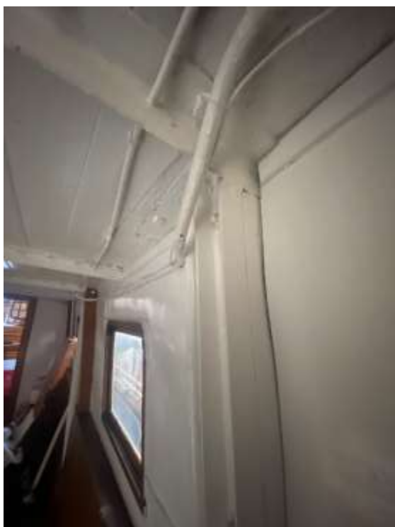
figur 67: Overgang mellom stålbjelke og profil, 2021.
