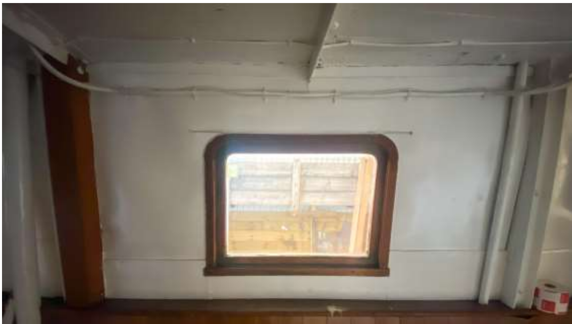
figur 66: Stålbjelker og profiler i overbygget, 2021.
