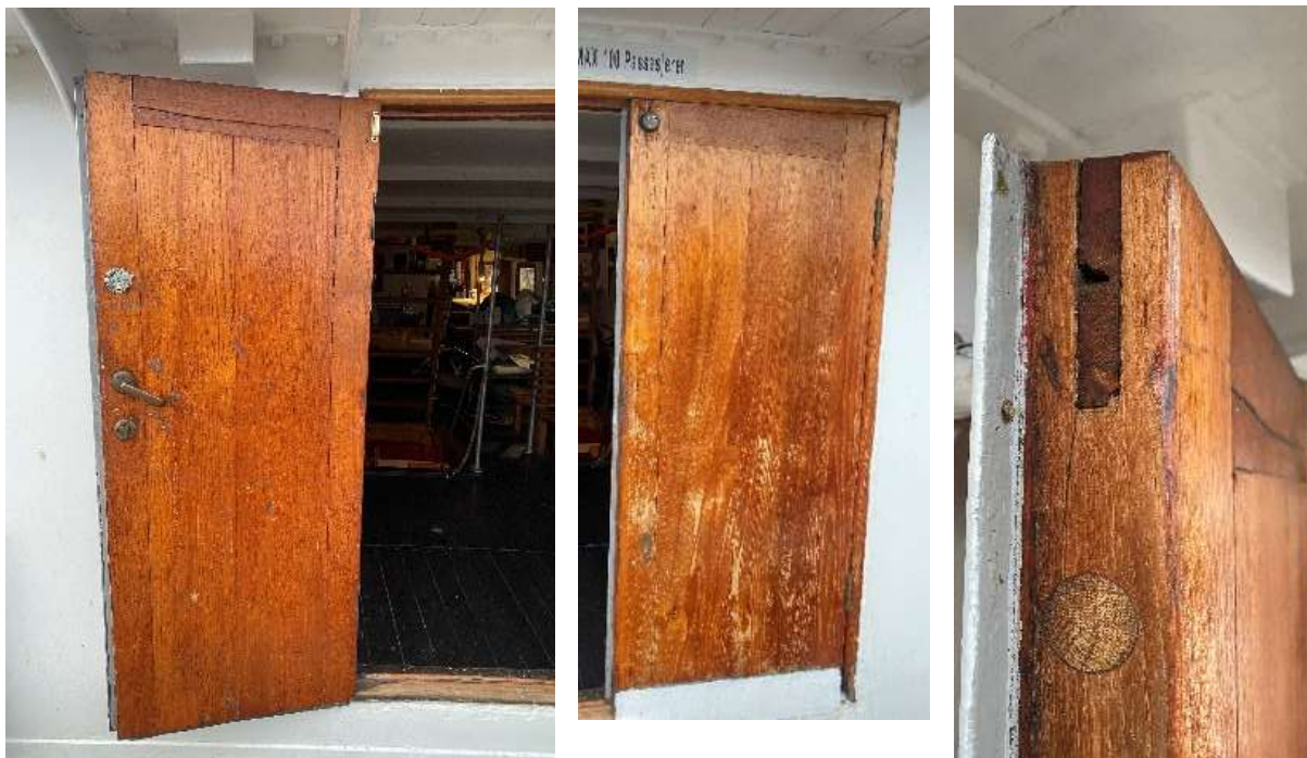
figur 72: Dobbeltthengslet dør i inngangspartiet til dekkssalongen (230), 2021. Spor etter gjenbruk.
