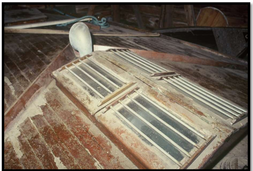
Skylight slik det så ut i 1998
