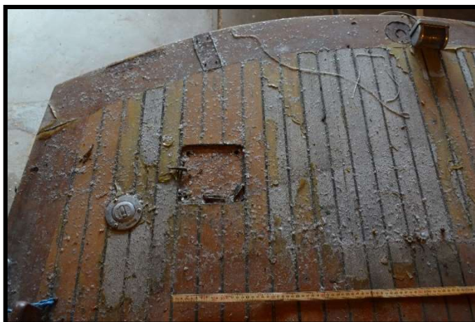
Akterdekket med utfresing til pullertmidt i bildet.
