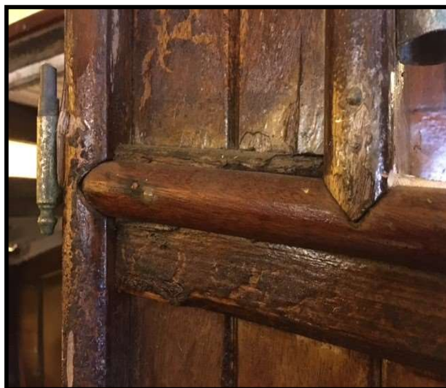
Detalj fra skott mot styrhuset.
