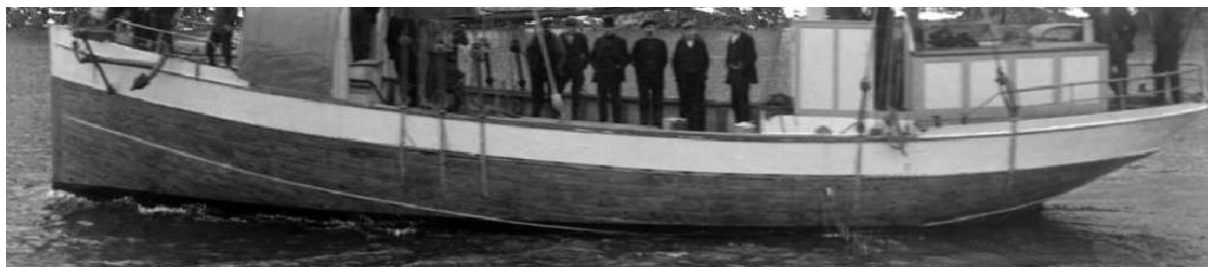
Figur 51 Utsnitt av figur 5, hvor vi ser at Reidulf hadde tykkere planker i kimmingen enn videre oppover i fribordet.
