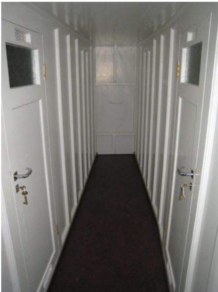
Ferdig korridor sett akterover. To dørar fører inn til lagerrom. på begge sider.
