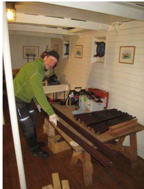
Alle deler til rekkverk klar for montering
