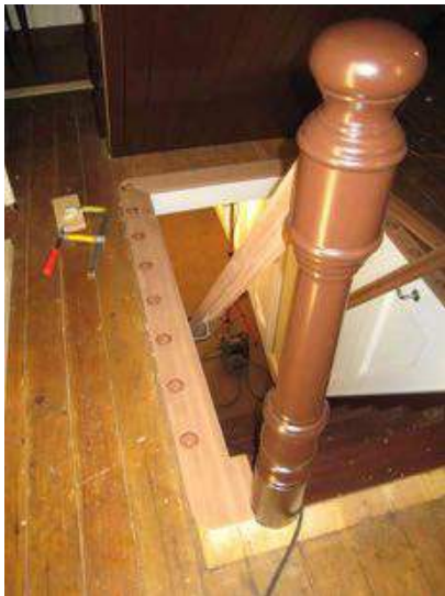
Meklar og bunramme for spiler blir tilpassa, beisa og lakka.
