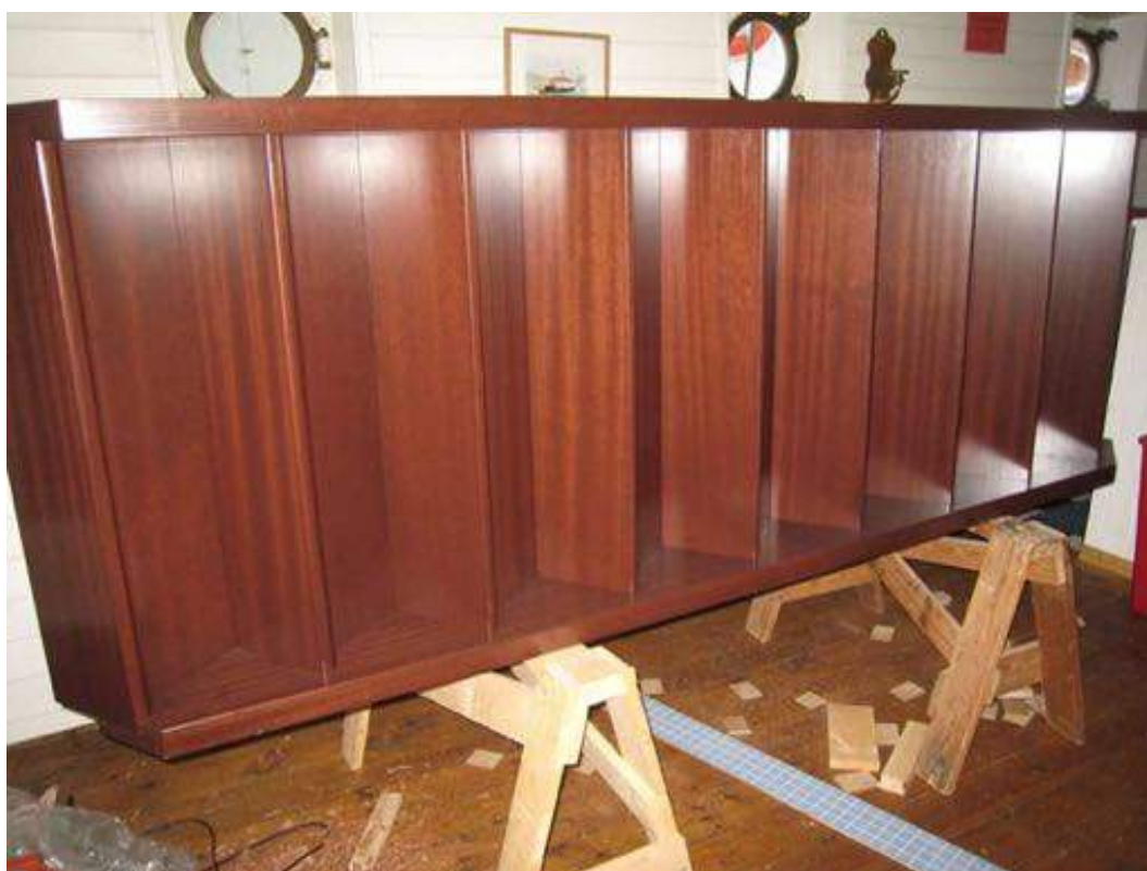
Framsida trapp klar for montering .
