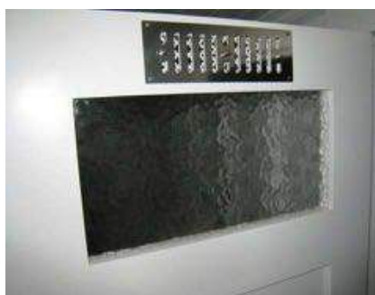
Dørblad med ramtre, fylling, sjablongglas og ventillirister.
