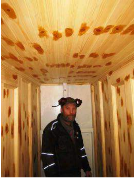
Skott og tak i korridor på plass med kvistlakk. Trappesjakt med eit strøk maling og sparkel.
