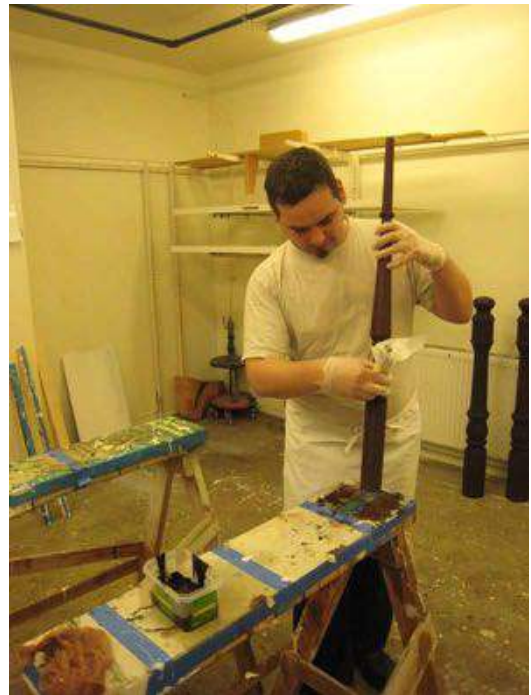
Beising av spiler, strøk to.
