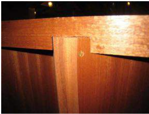
Detalj trappetrinn og vange på bakside.
