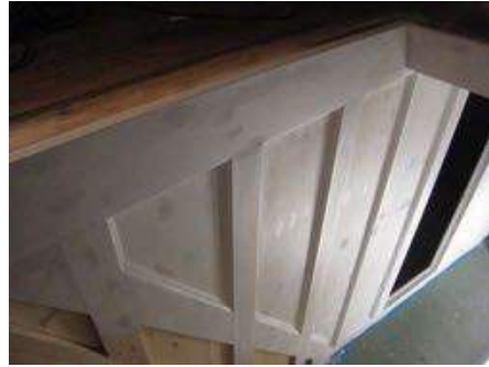
Skott og tak i korridor på plass med kvistlakk. Trappesjakt med eit strøk maling og sparkel.
