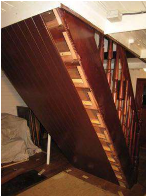
Bakside av trapp til shelterdekk er retta av og kledd med mahognipanel.
